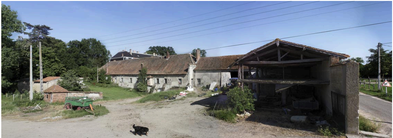
Vue d'ensemble de la cour sud, depuis le nord.
