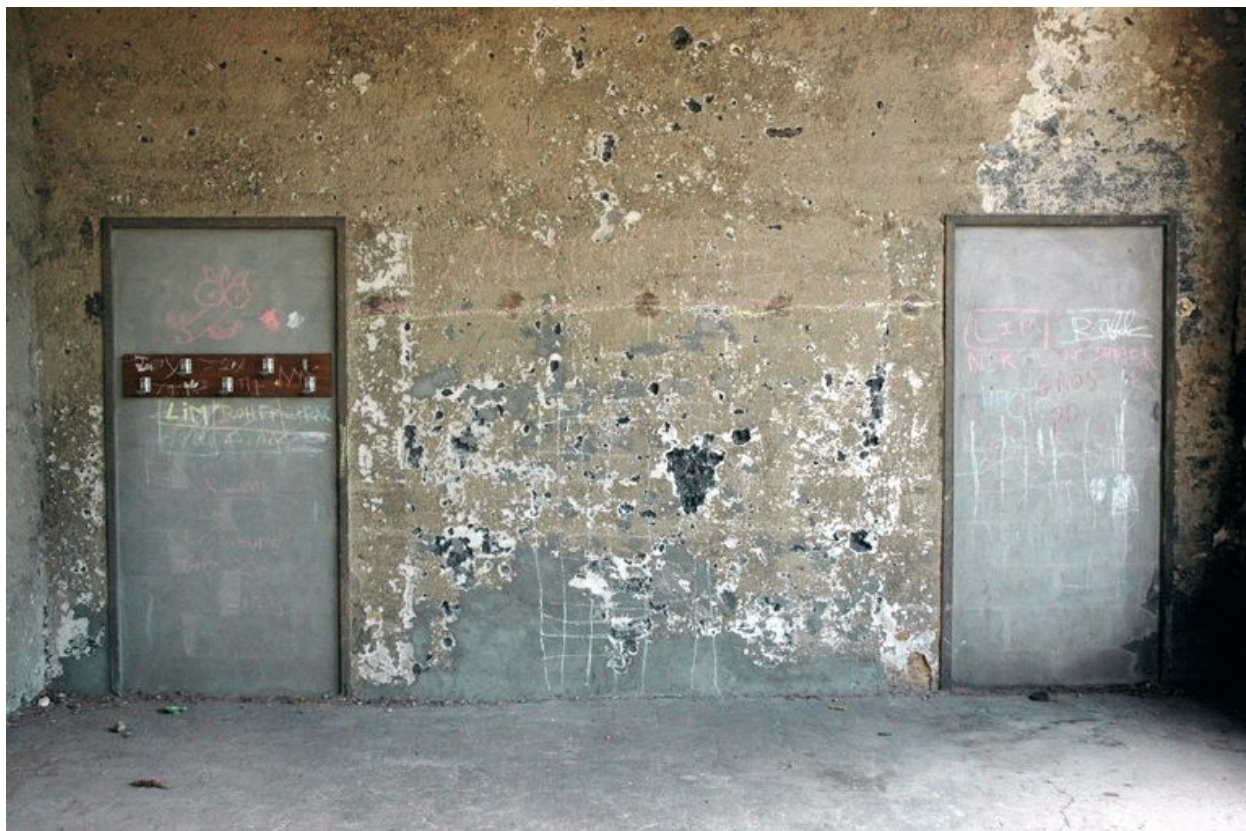
Bâtiment de la galerie, portes murées donnant autrefois accès à l'escalier desservant le premier étage
