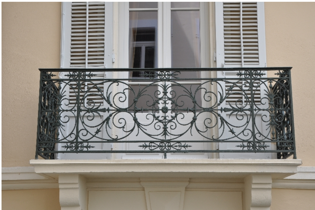
Balcon du 2e étage, façade nord
