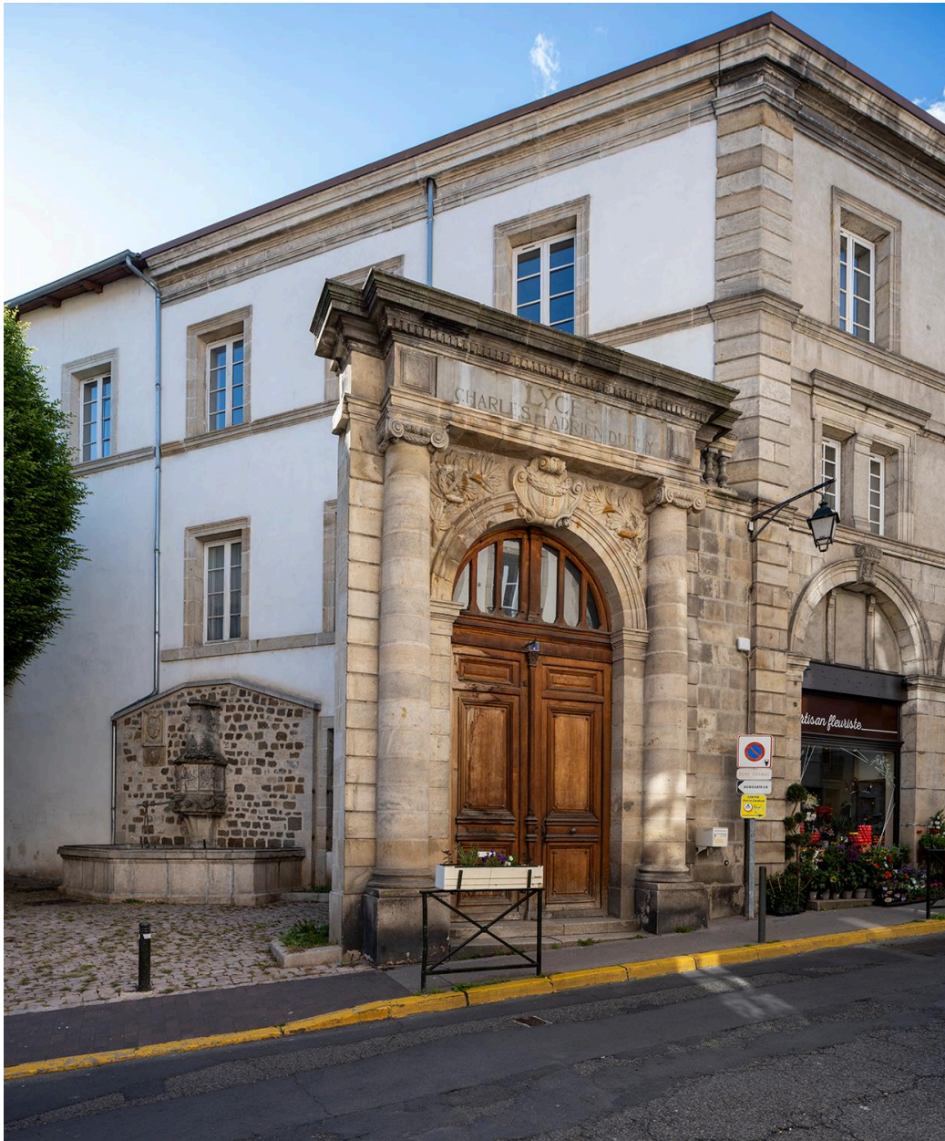
Ancienne entrée du lycée, bâtiment J et fontaine du Théron (13e s.), en 2025
