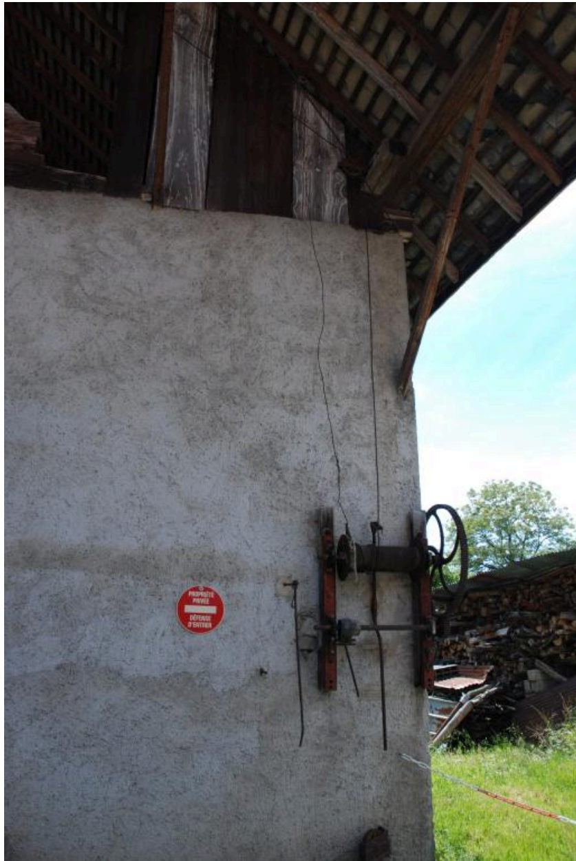
Détail du treuil du monte-foin.
