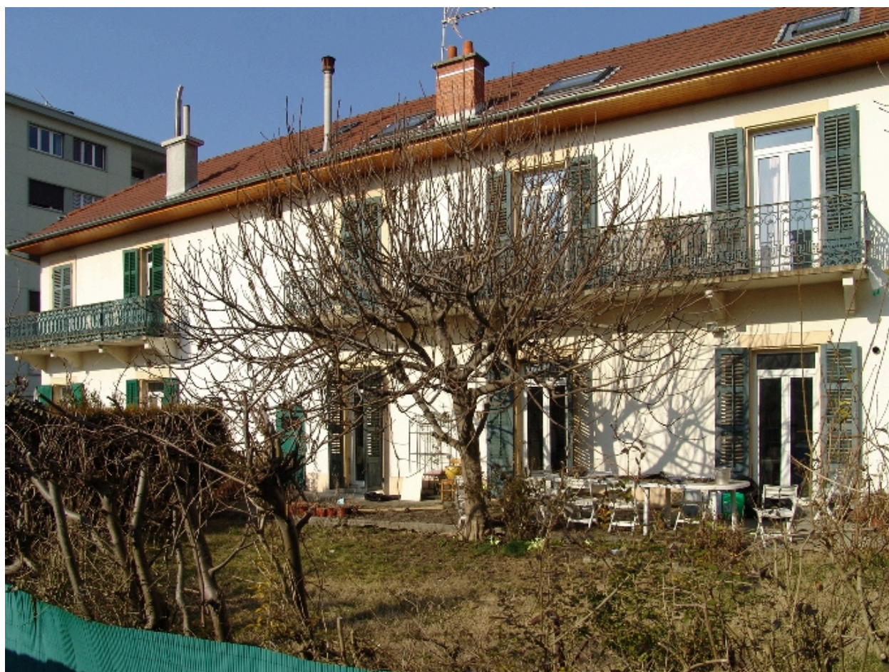
Façade postérieure sur jardin
