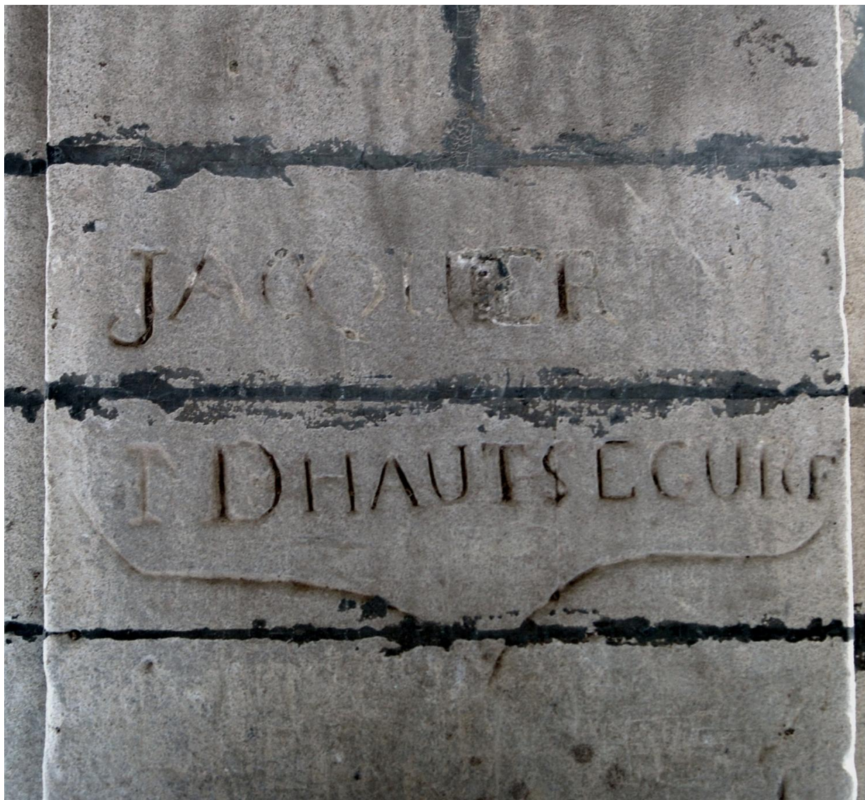
Bâtiment A, galerie sud : graffiti ancien sur un pilier
