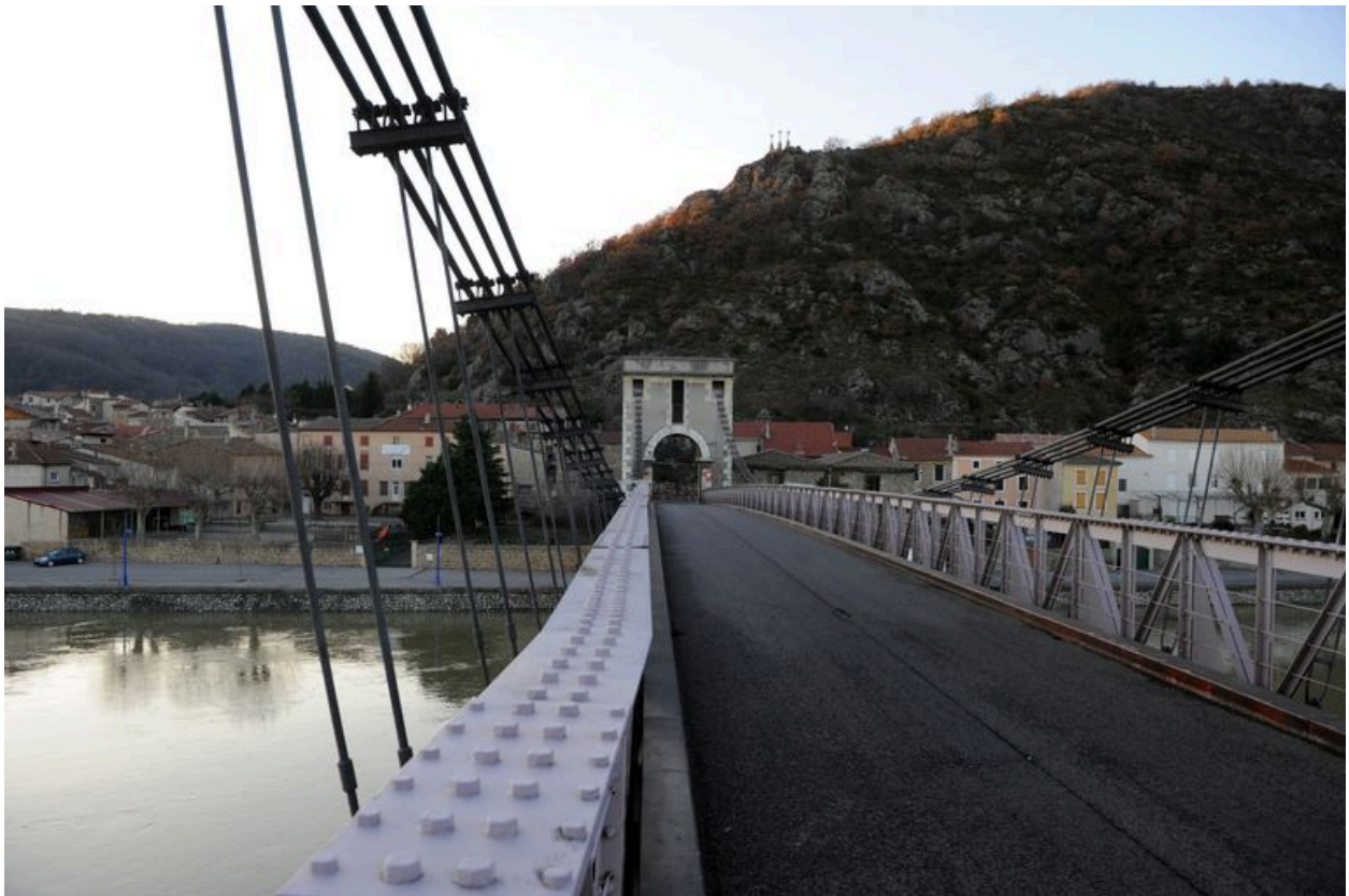
Travée droite, de dessus, vue partielle : parapet et câble porteur (depuis la rive gauche)
