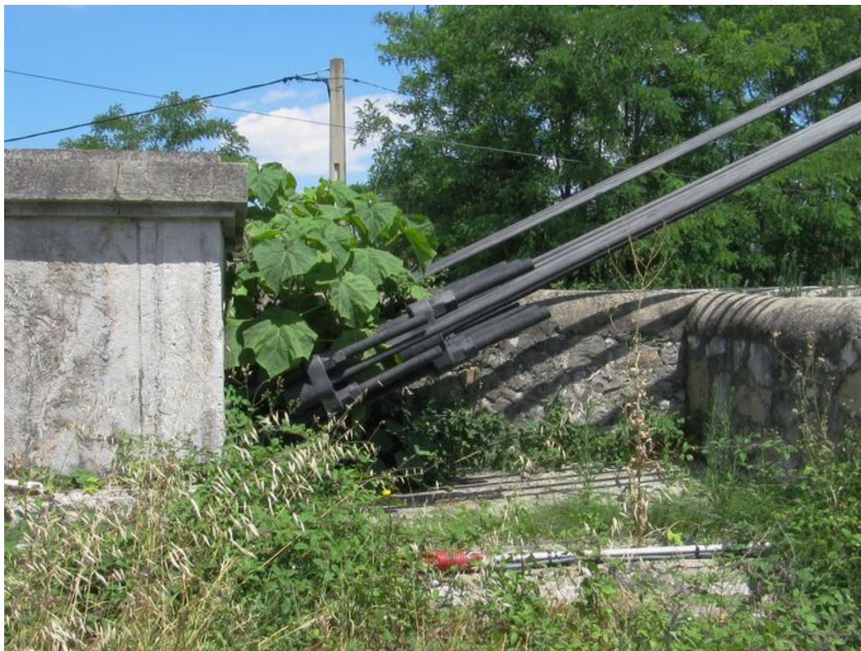
Massif d'ancrage de la rive droite
