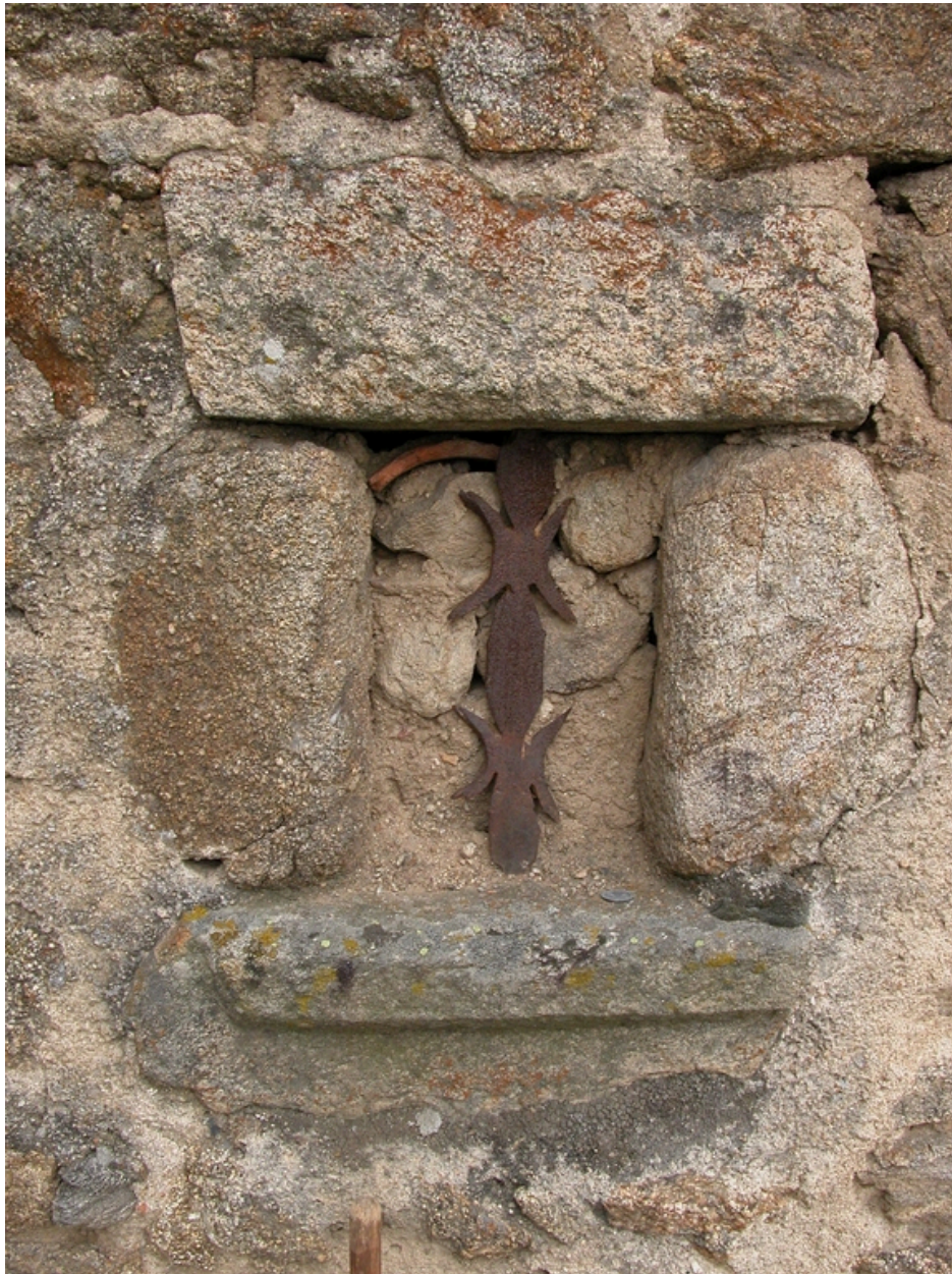
Détail de jour avec barreau en lame de fer forgé découpé (dit aragne), au Pizet (1999 ZL 16, non repéré).
