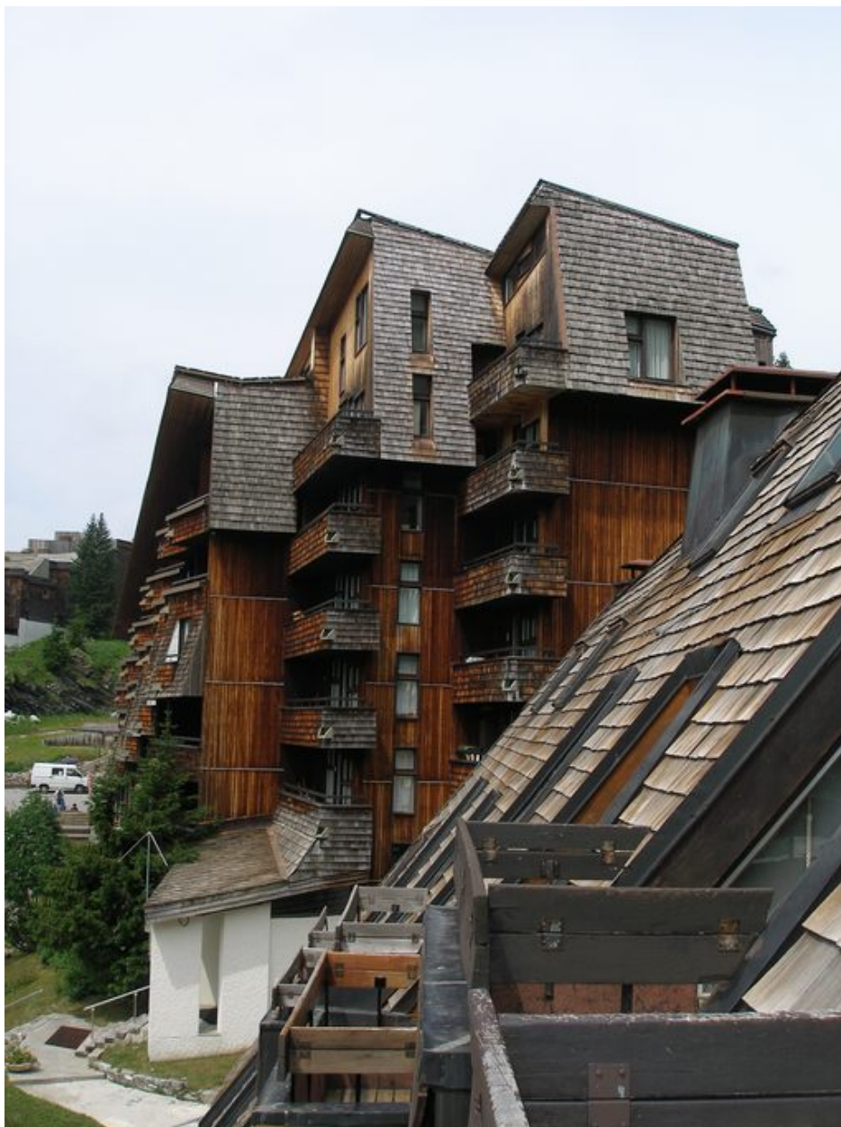
Détail des parties hautes de l'élévation sud
