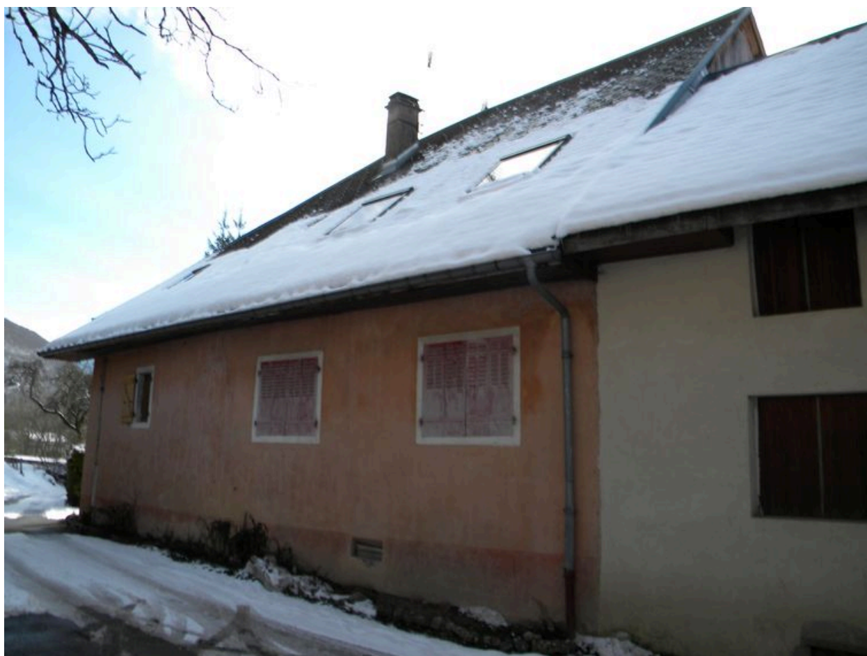
Vue de la façade sur rue avec une autre ferme accolée.
