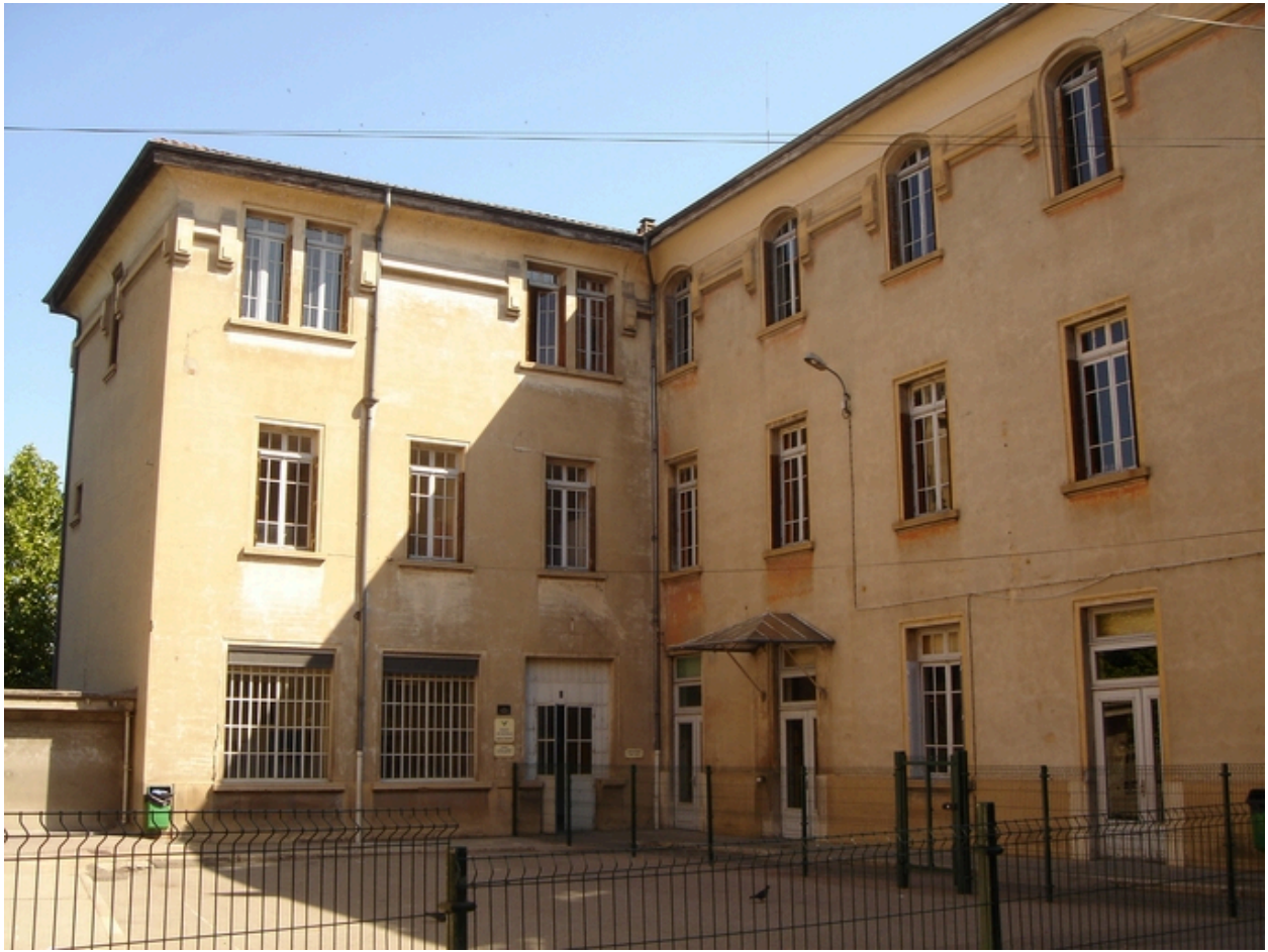
Façade sur cour
