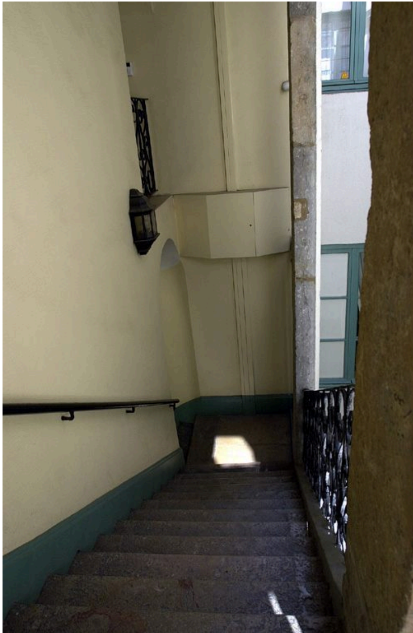
L'escalier : à gauche, le mur-noyau
