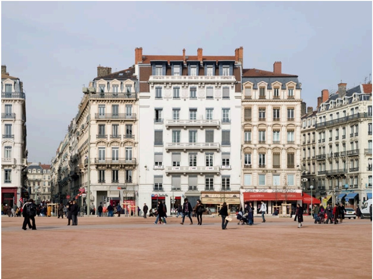
Vue d'ensemble (1er immeuble à gauche), en 2009
