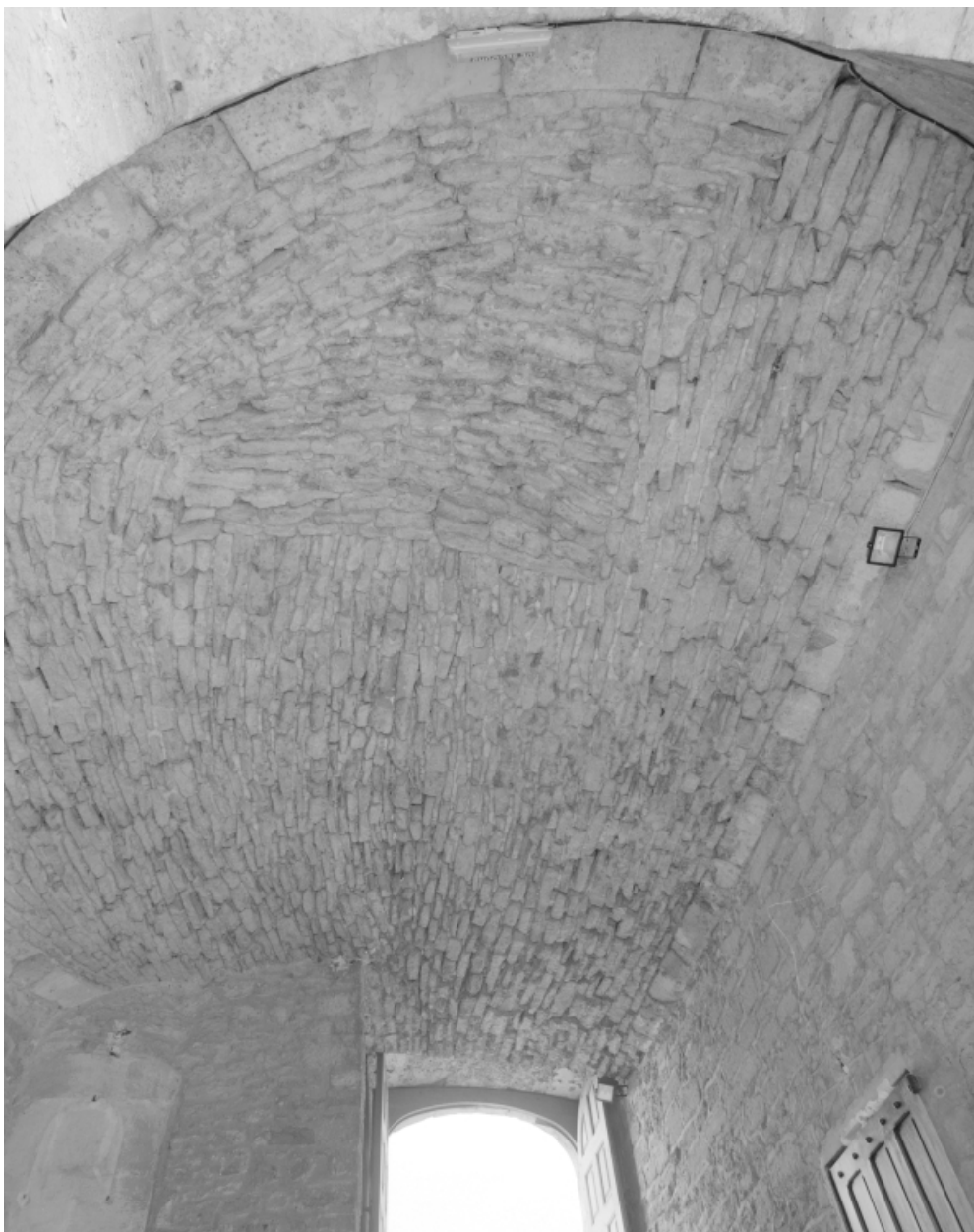
Bâtiment sud. Tour sud-ouest. Appareil de la voûte plate du passage entre basse-cour et cour du puits.
