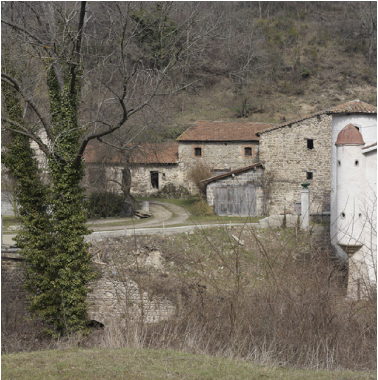
Vue générale du bâtiment de dépendances, depuis le sud.
