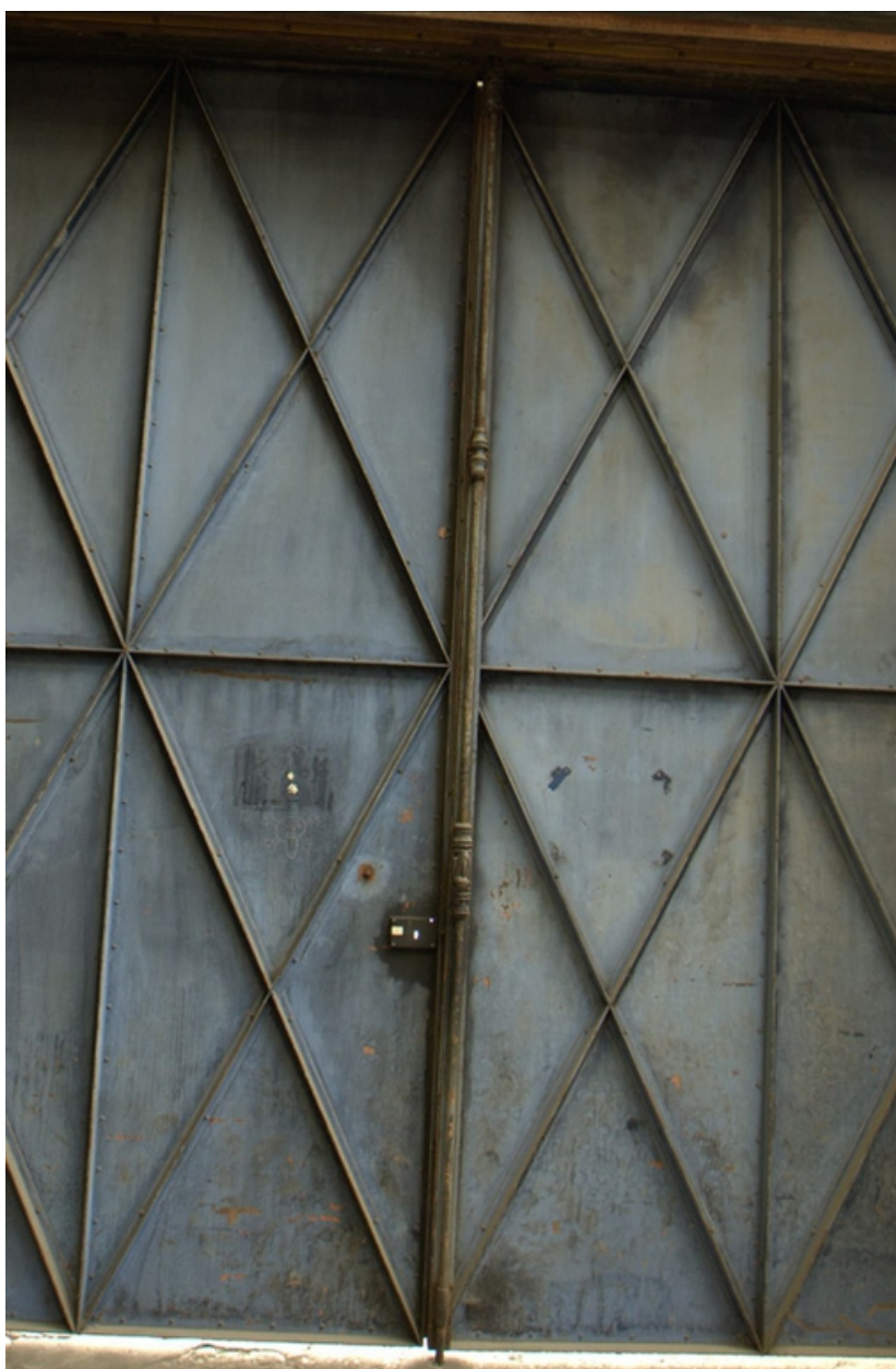
Portail sud de la halle centrale
