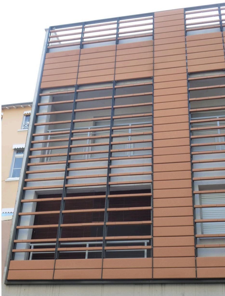
Détail panneau ajouré recouvrant la façade principale
