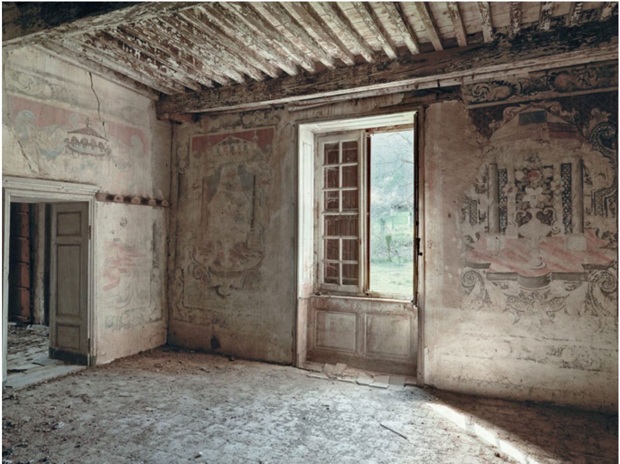
Angle sud-ouest : vue du panneau à droite de la cheminée et des panneaux de part et d'autre de la fenêtre.
