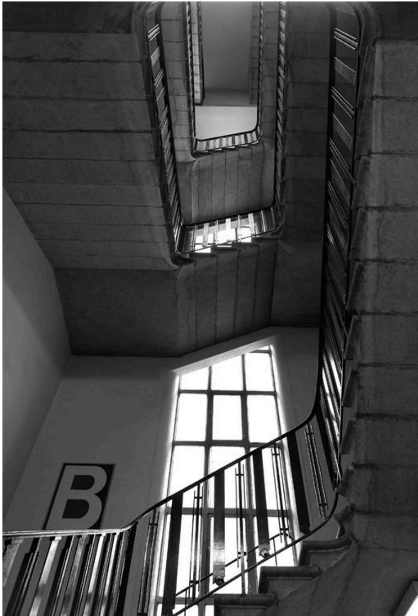
Escalier sud, vu depuis le bas
