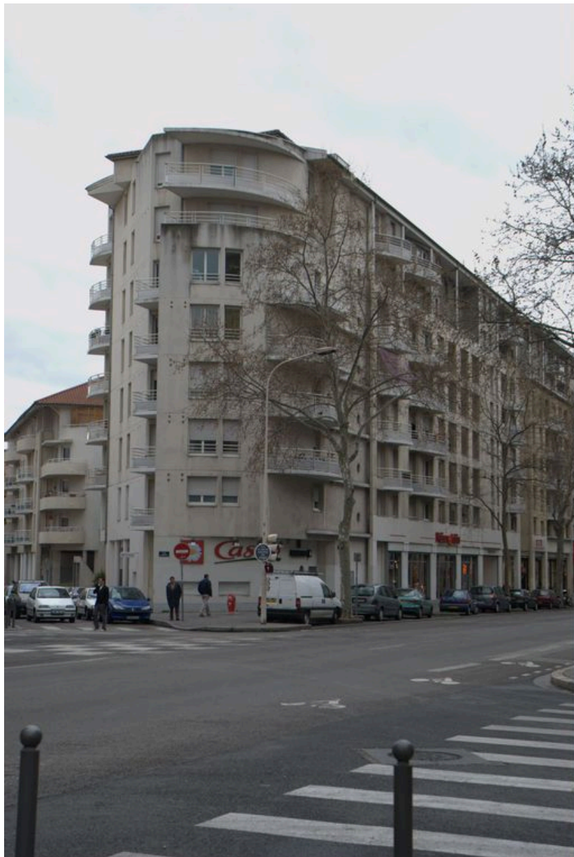
Vue générale depuis l'est
