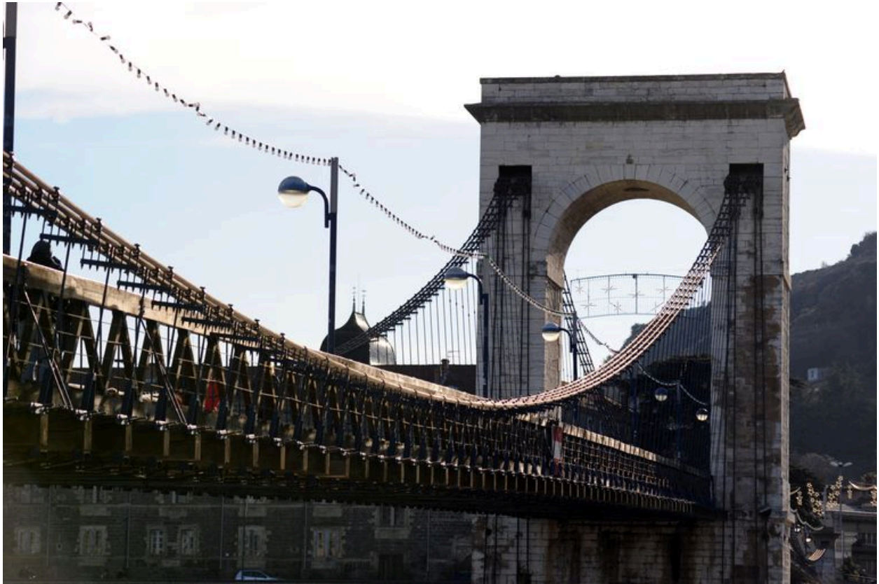
Travée gauche, face amont, vue générale (depuis la rive gauche)
