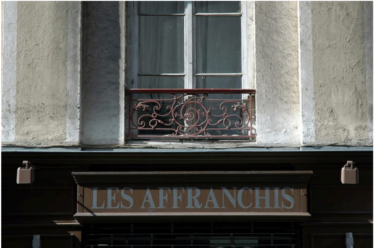
Élévation antérieure : garde-corps de l'entresol
