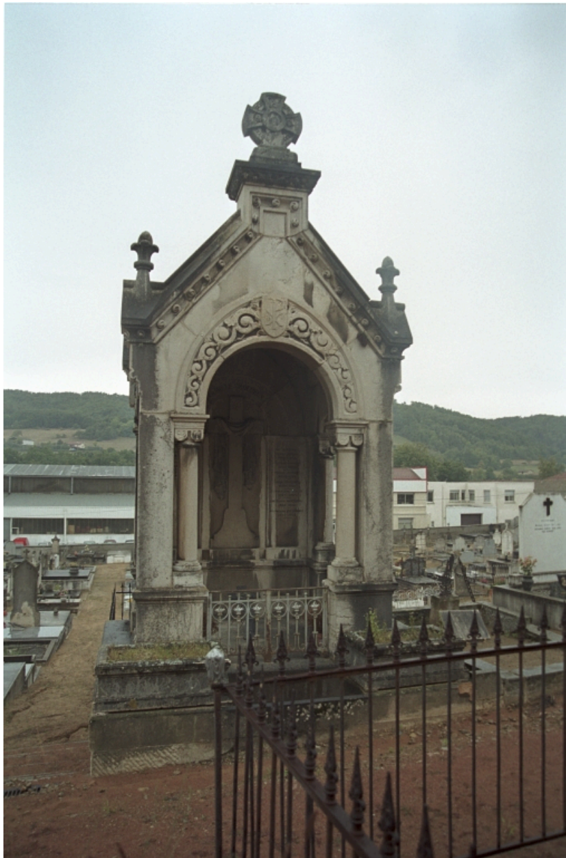
Vue d'ensemble une chapelle mortuaire.
