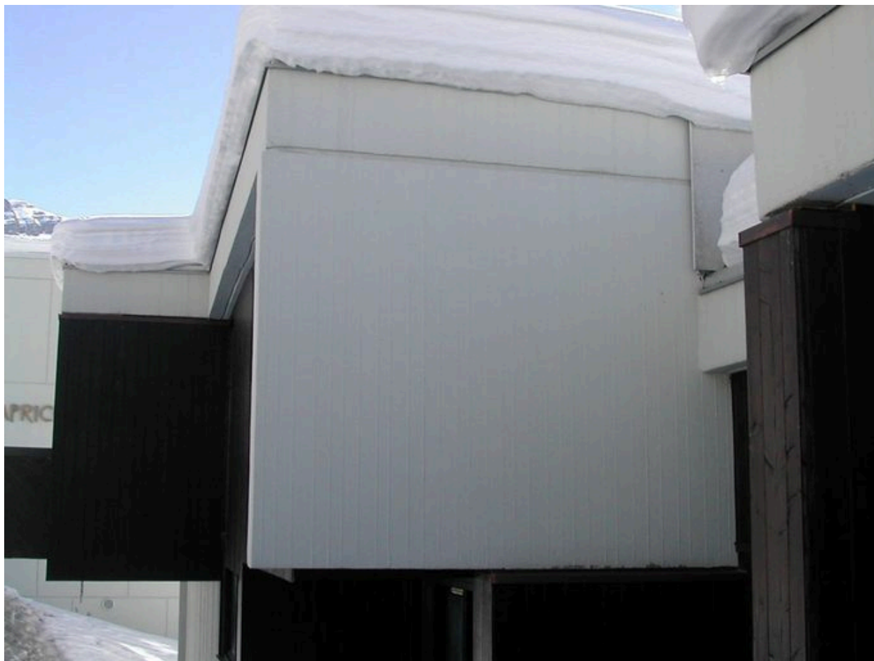
Détail de l'enduit de la façade antérieure
