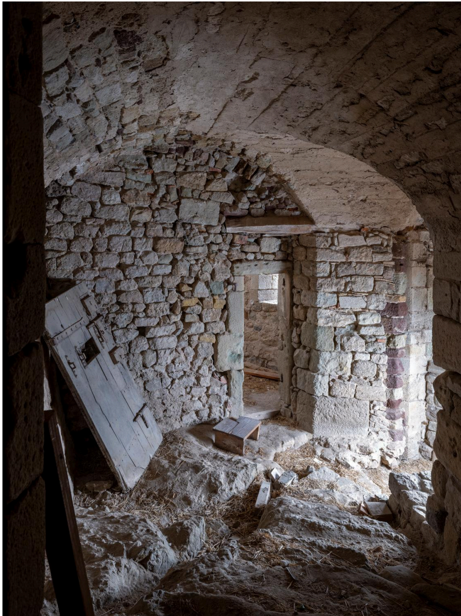
Aile nord, sous-sol : rampe d'accès et vue vers un ancien cachot (?)
