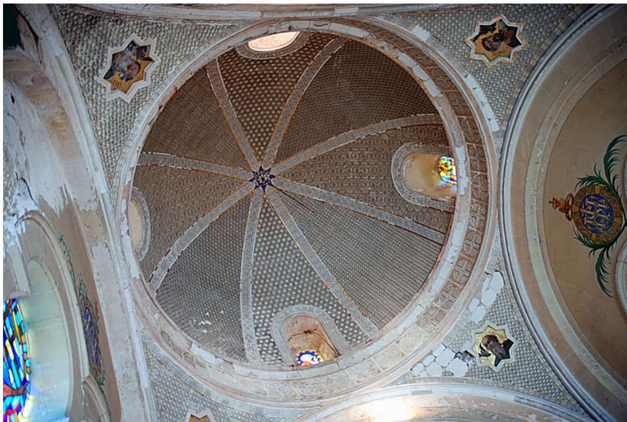
Coupole, vue d'ensemble
