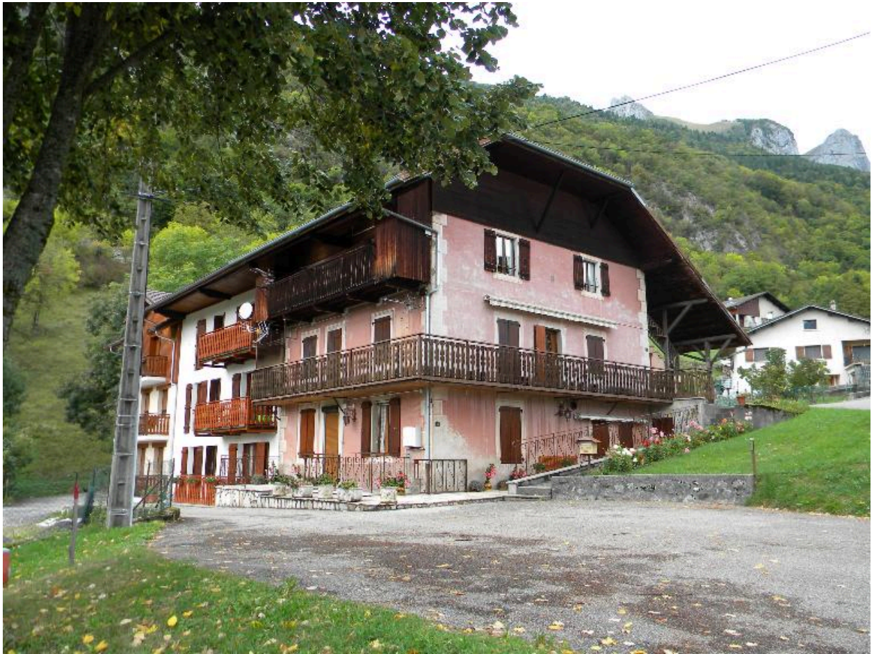
Vue d'une ancienne aux chainages peints (2008 C3 303)
