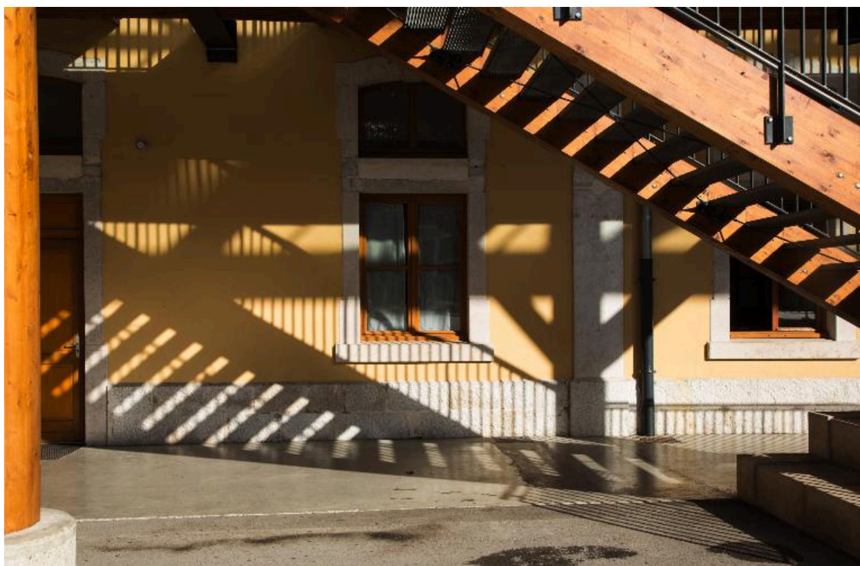
Cour 2 : galerie, escalier.
