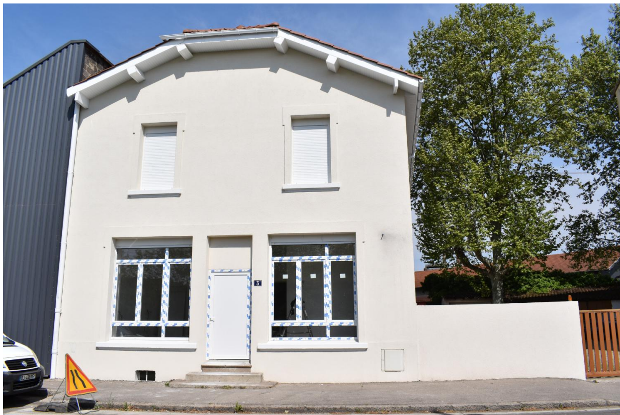
Véninov - habitation en rénovation - rue Eugène Maréchal
