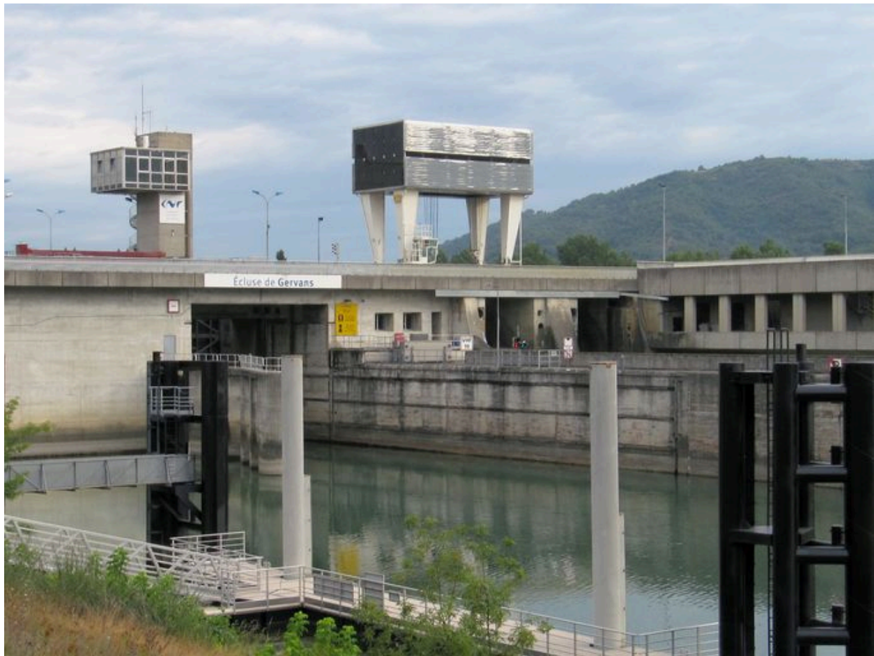
Ecluse, vue partielle face aval (depuis la rive droite)
