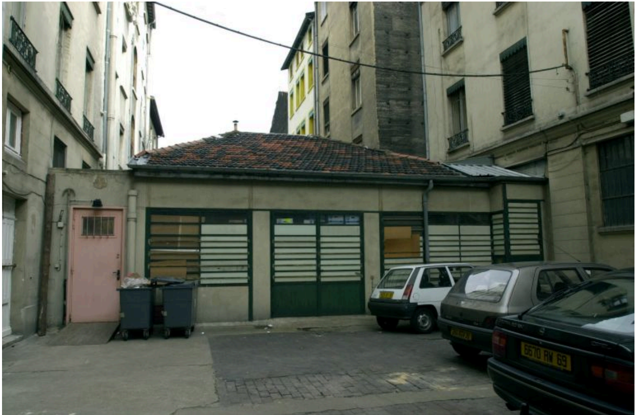
Vue du bâtiment construit au nord de la cour
