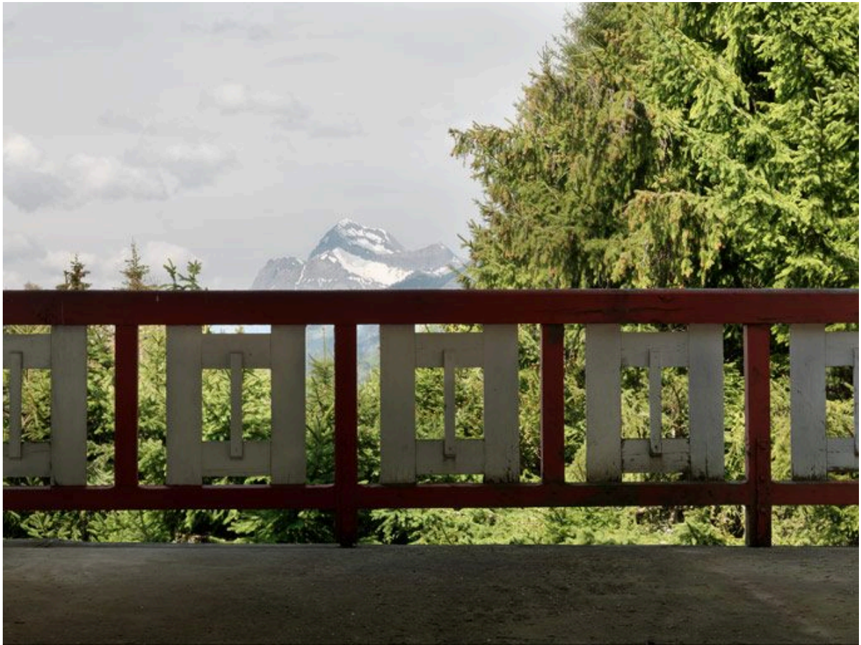
Détail du garde-corps du balcon ouest
