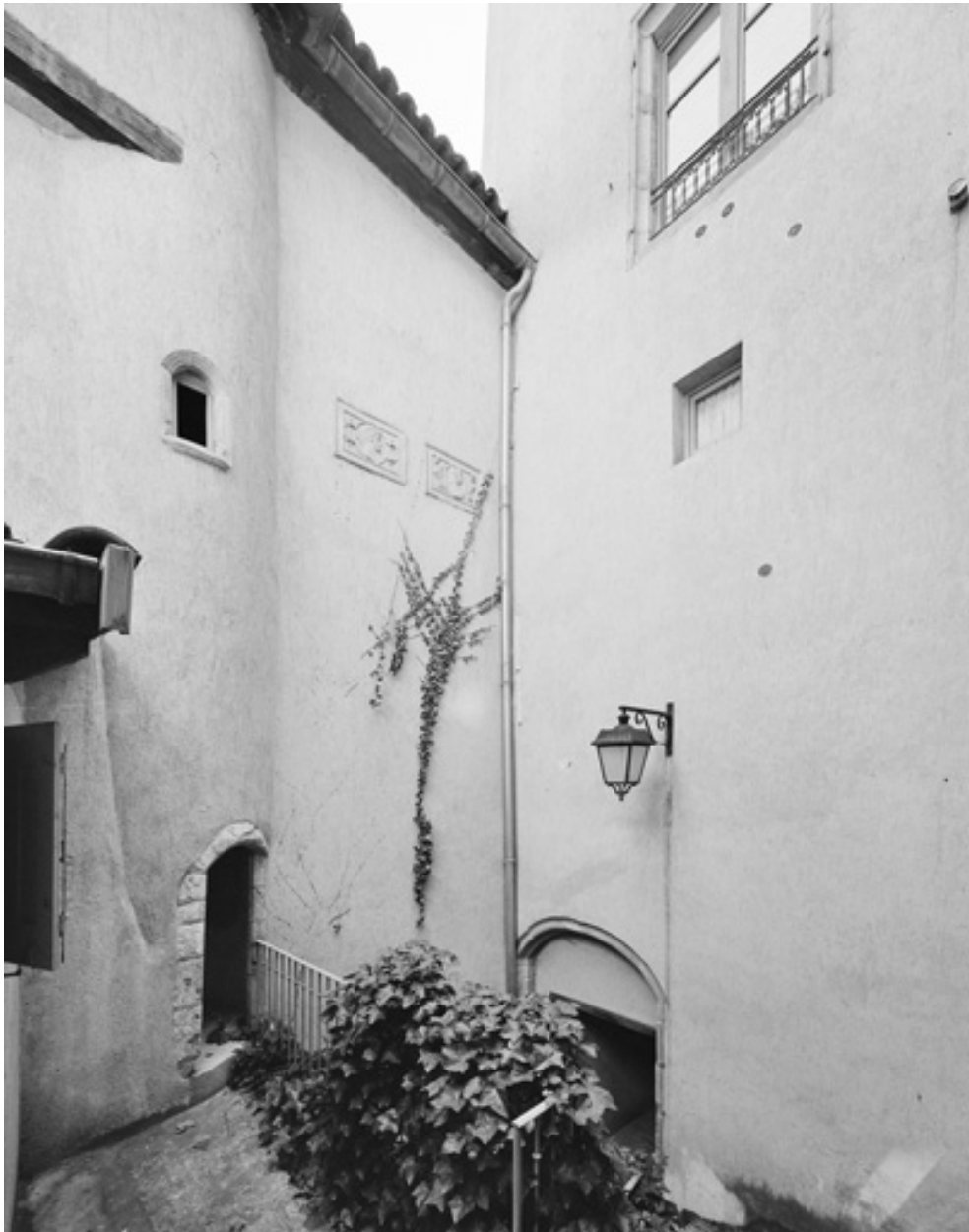
Cour intérieure, vue partielle du mur sud, escalier demi-hors-oeuvre à gauche.
