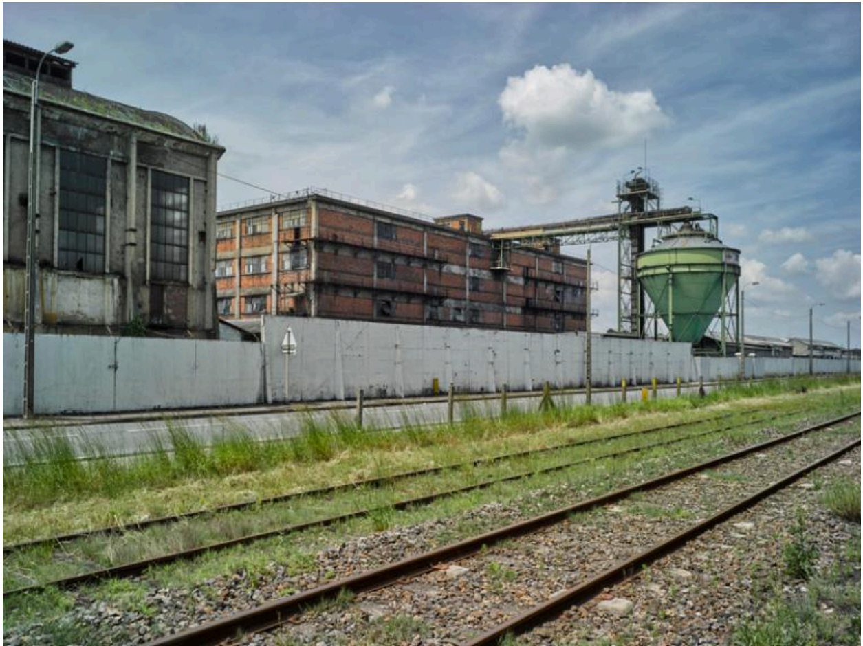
La voie ferrée près des usines Dunlop de Montluçon.
