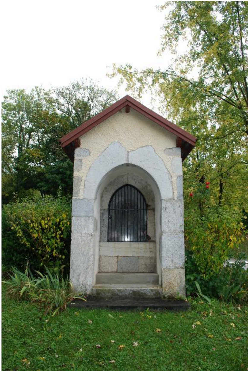
Vue d'ensemble de face de l'oratoire.
