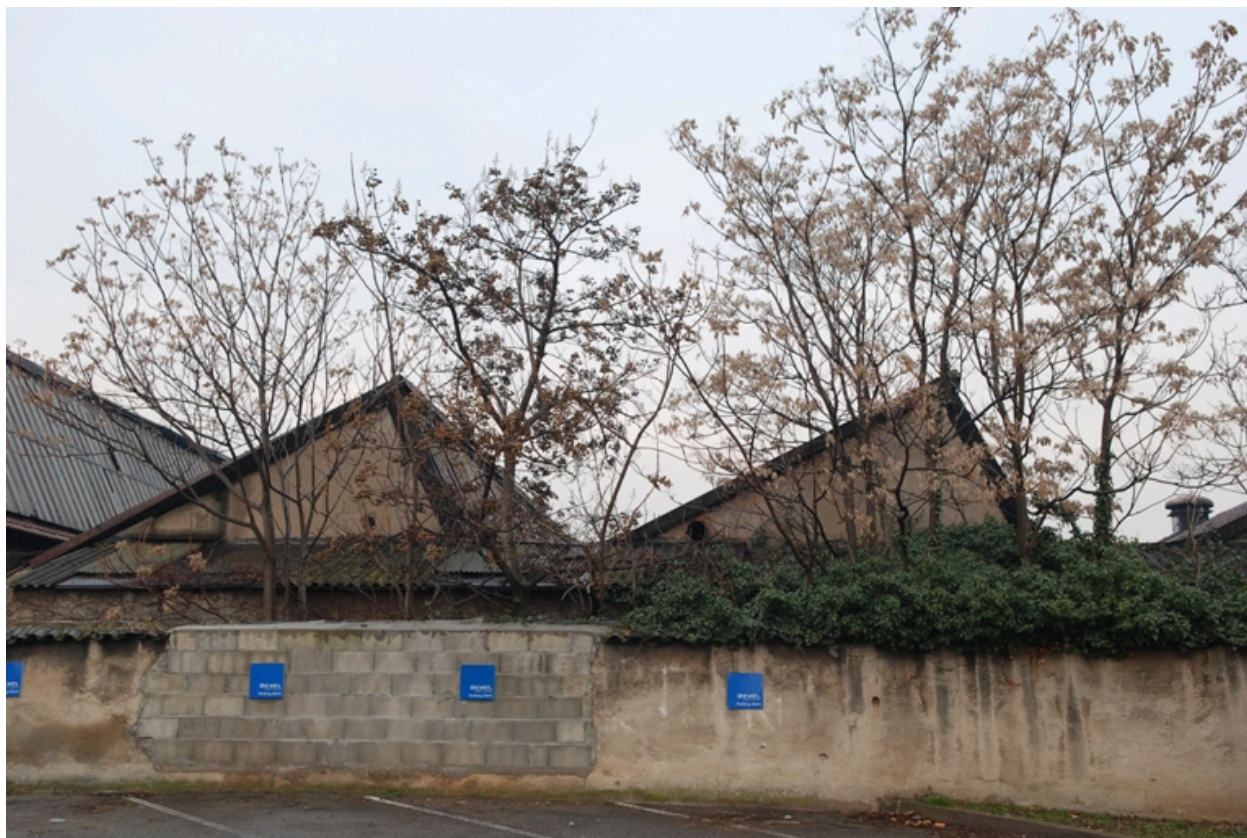
Vue nord détail
