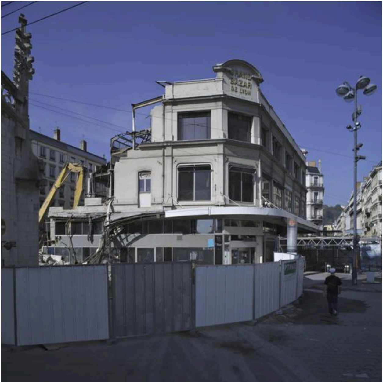
La démolition du Grand Bazar, août 2005
