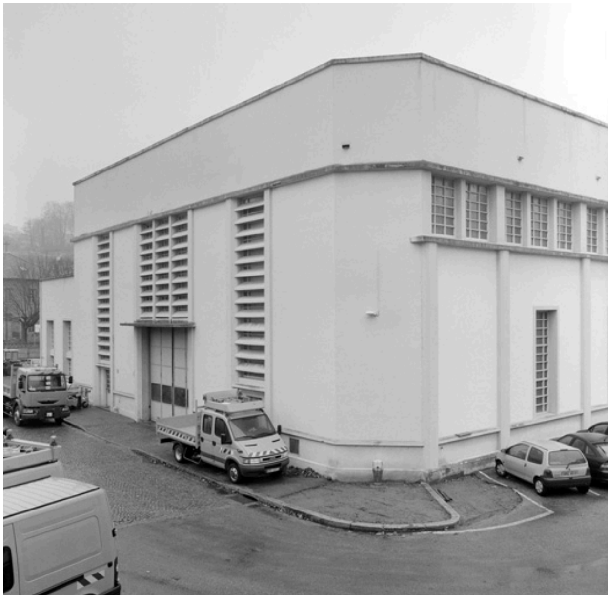
Façade sud, vue sud-est
