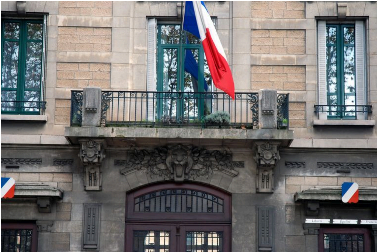
Elévation principale, détail du balcon du 1er étage
