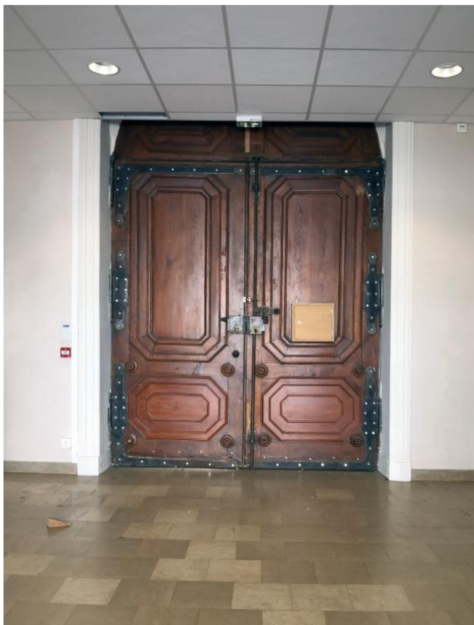
Porte d'entrée du lycée, revers
