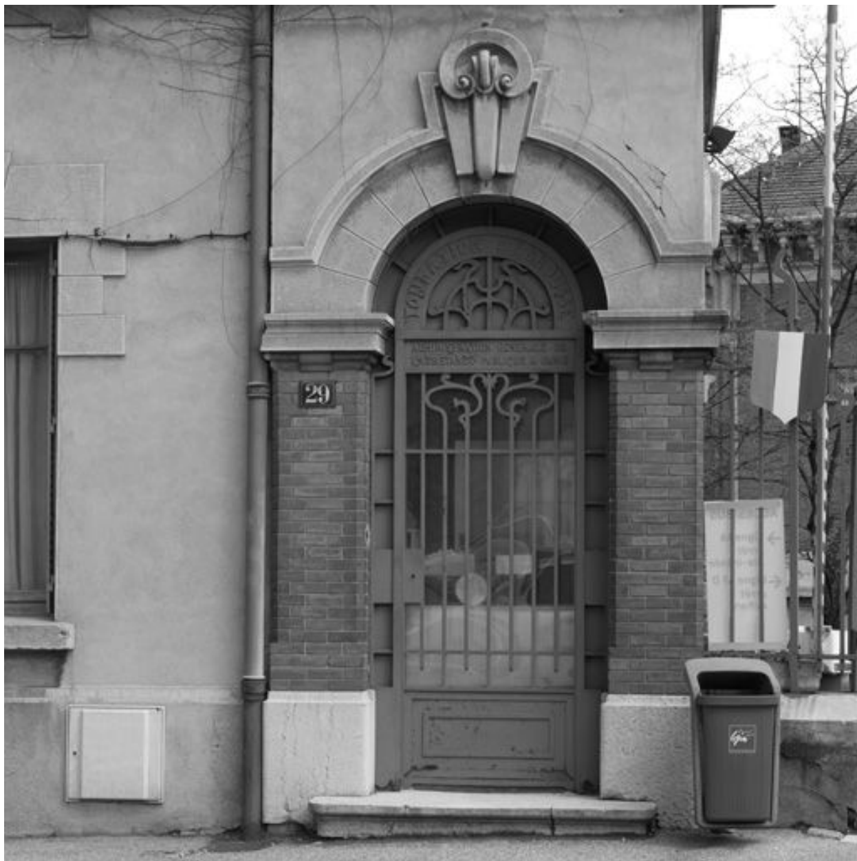
Bâtiment 14, façade ouest, détail de la porte en ferronnerie
