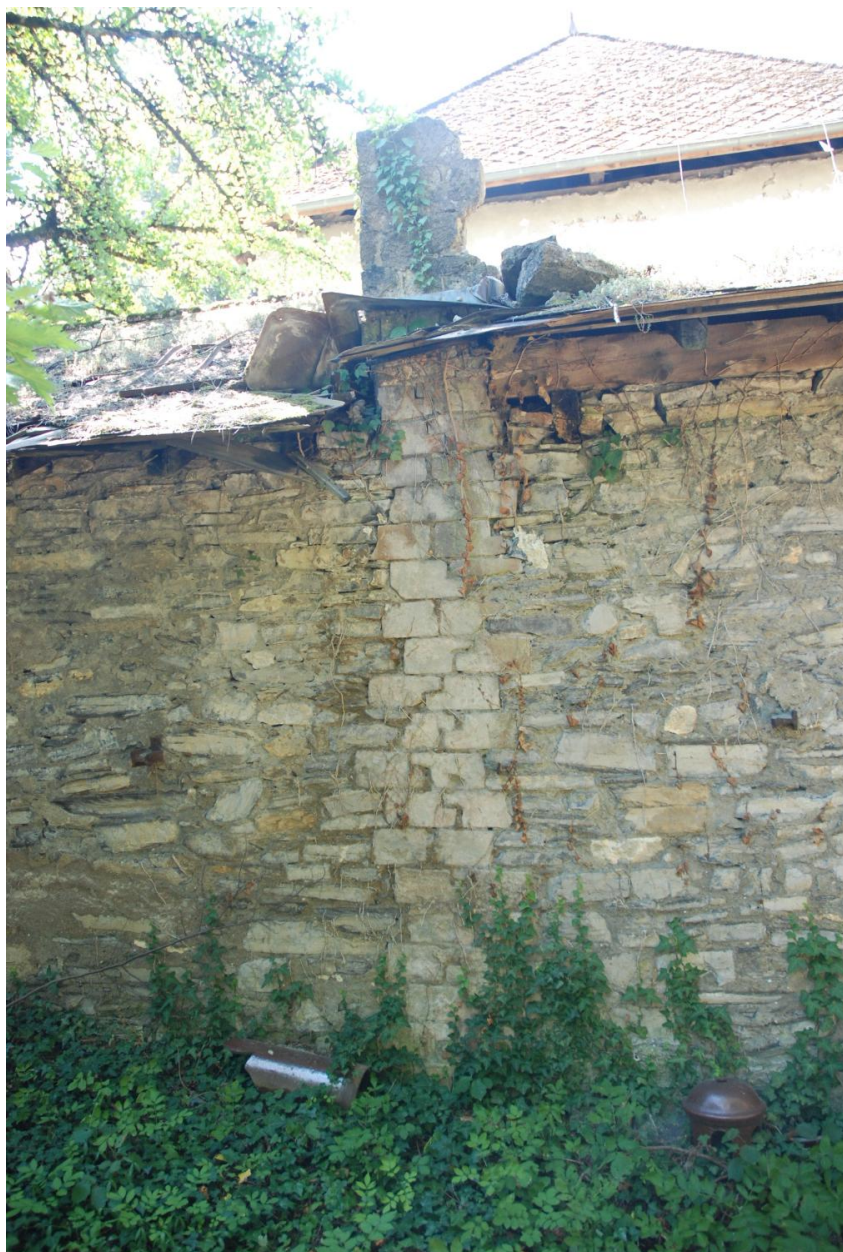
Détail du mur arrière de la dépendance : appareillage du conduit de cheminée.
