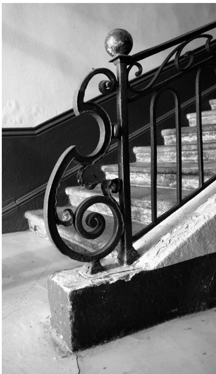
Escalier, détail du départ de rampe.
