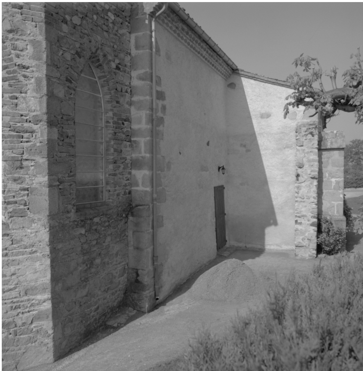
Vue du mur nord à son raccord avec le chevet.
