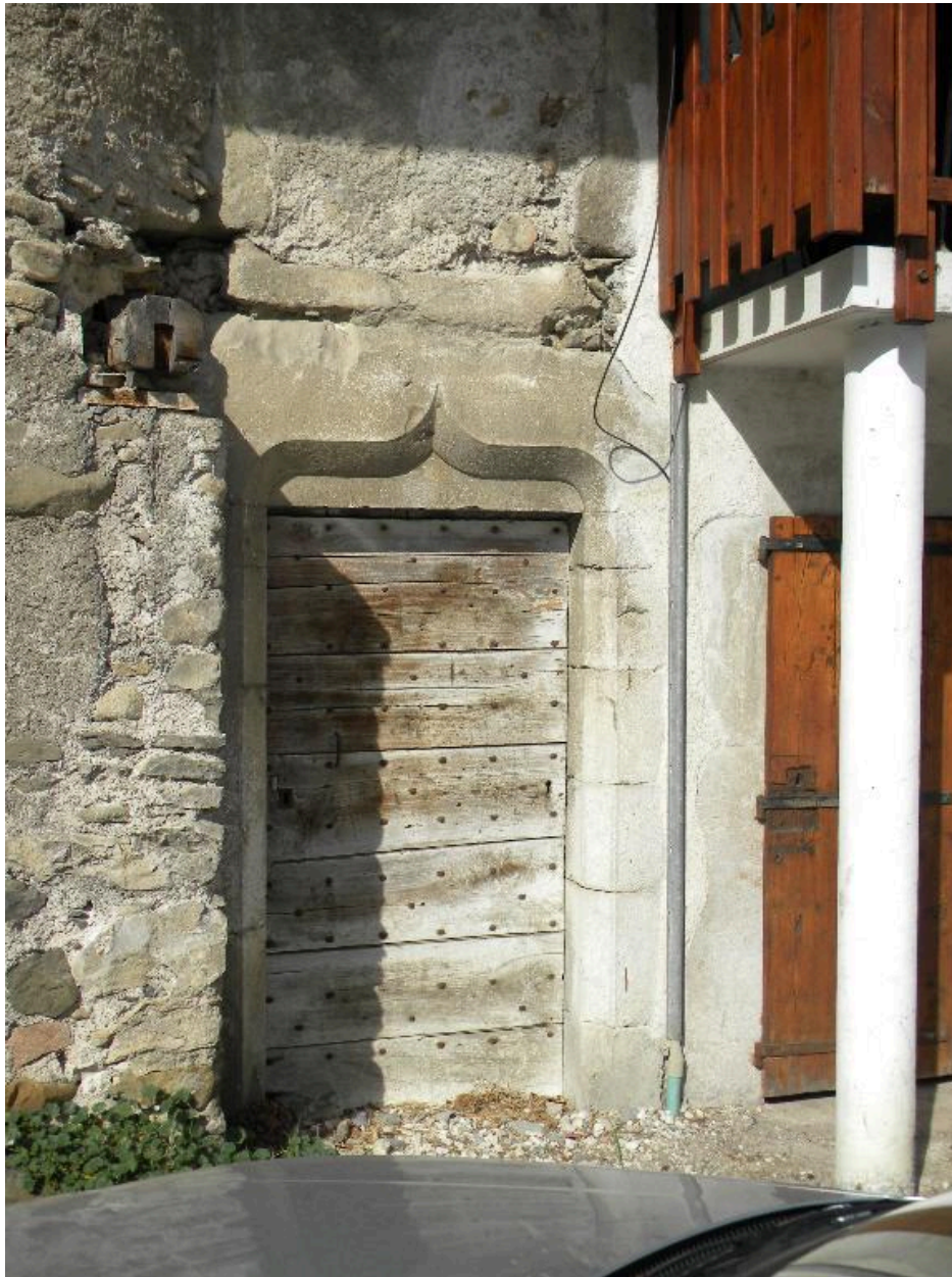
Détail de la porte principale.
