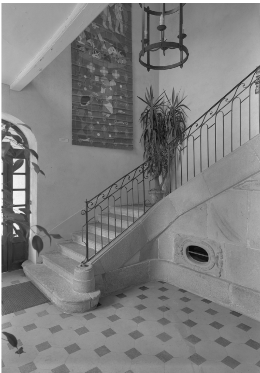
Corps de logis central, rez-de-chaussée : vue générale intérieure du départ de l'escalier.
