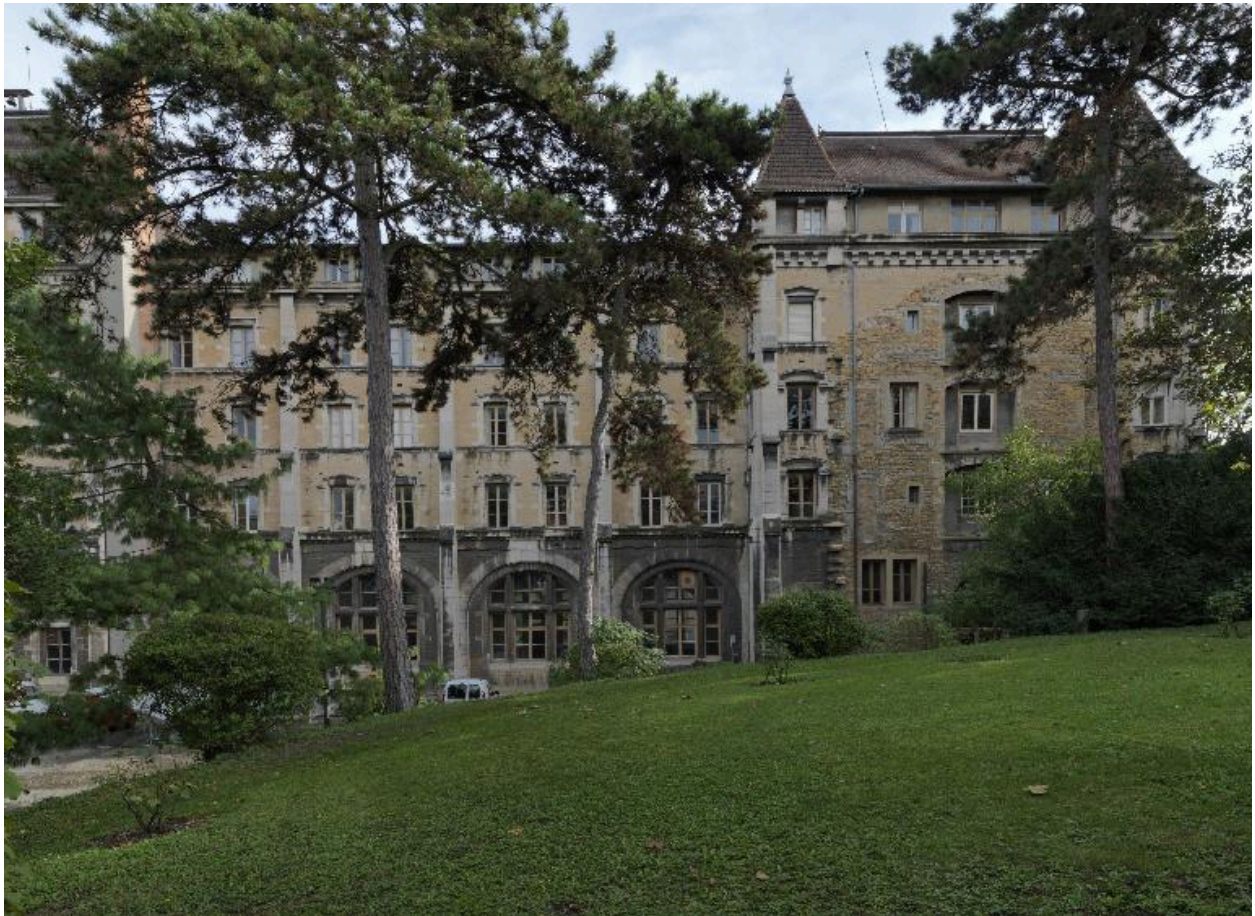
Elévation antérieure, partie sud-ouest
