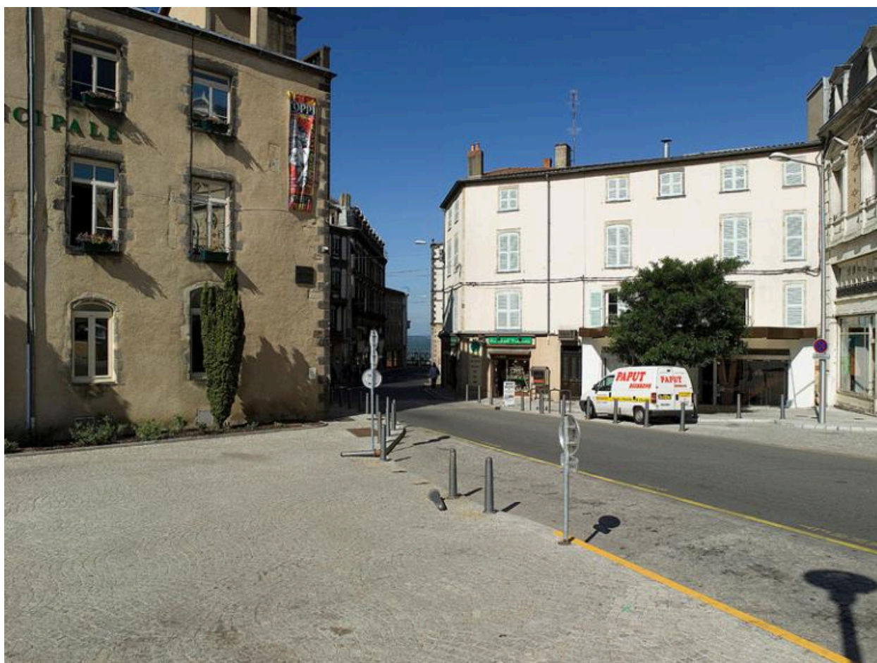
Extrémité ouest de la nouvelle place.
